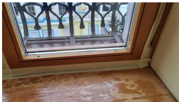
zalepená okna proti úniku tepla
