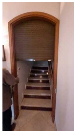
schodiště do 2.NP
