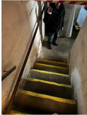
schody do sklepa
