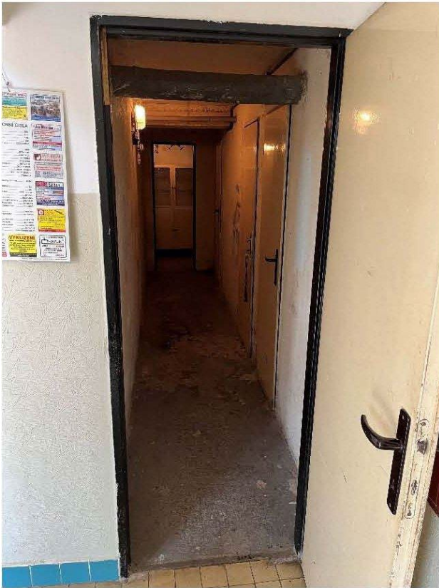
Vstup do sklepa – pohled 1
